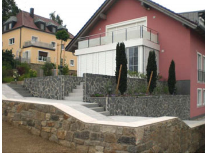
Mauer für abfallendes Gelände Treppen und Terrassen schön eingerahmt mit Natursteinmauern nach Maß
